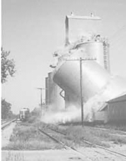
Рис.1 – Неупругий коллапс в емкости хранения цемента расположенной вблизи маневровой железнодорожной магистрали.
